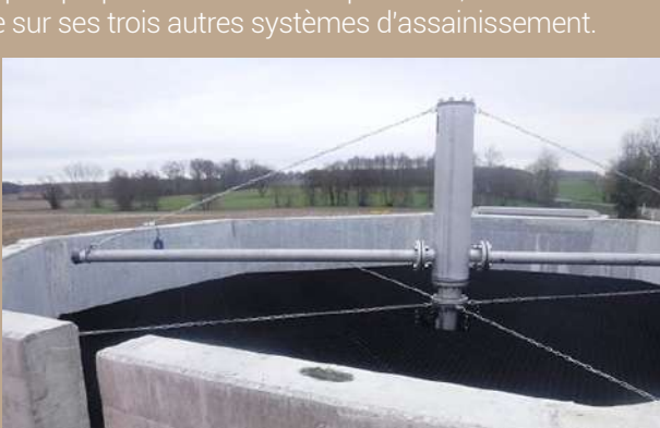
De gauche à droite : arrivée des eaux dans un dégrilleur automatique, passage dans le lit bactérien et répartition sur les filtres.
